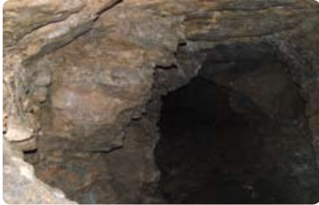
L'ingresso della galleria “Cava a Piano” The gate of the tunnel “Cava a Piano”.
